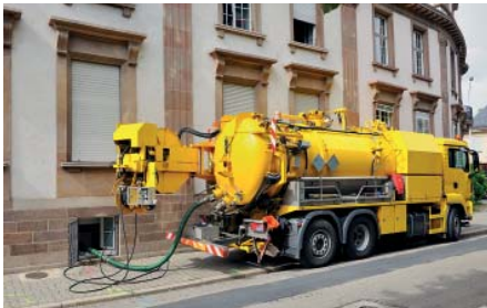
Rohrreinigungsunternehmen im Einsatz
